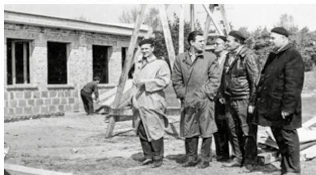
W czasie budowy grudziądzkiego hangaru
